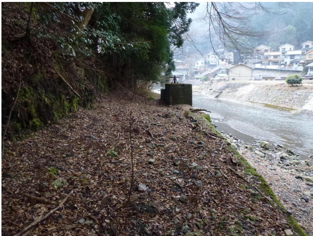
以下 導水路跡
