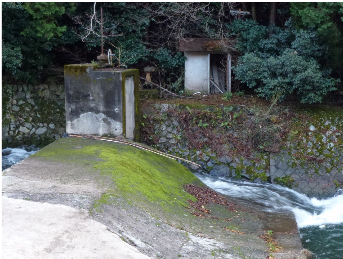
排砂ゲート跡
