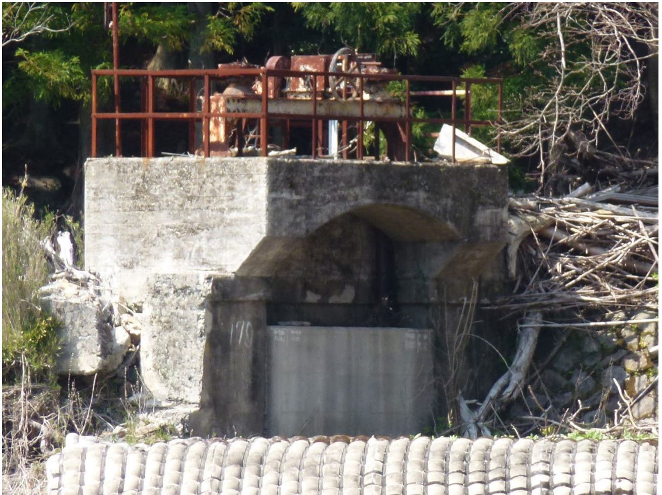
導水路入口制水門跡
