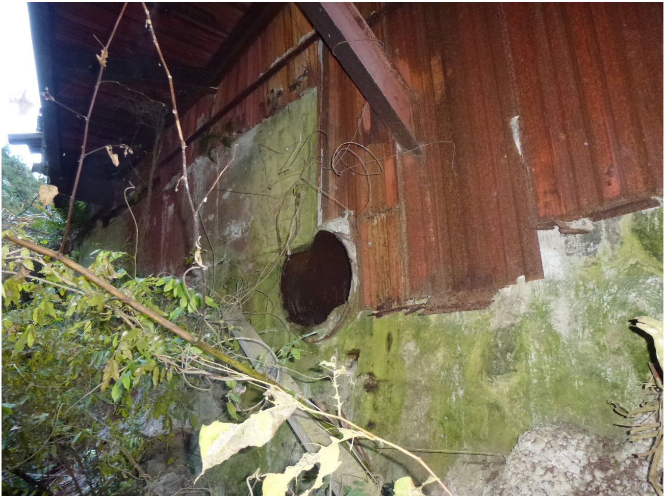
工場の側面に水圧管跡（対岸から水管橋で導水）
